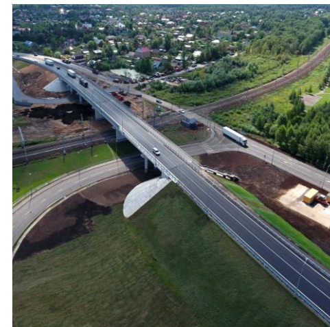
Автомобильная дорога с искусственными сооружениями «Западная хорда» Ростовская область
