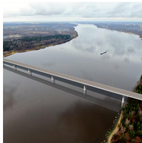
Highway «Irkutsk Bypass»
